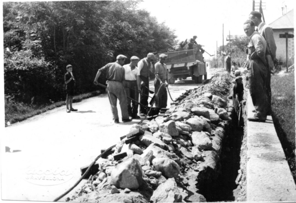
Ultimi ritocchi alla trincea, catramatura del cavo prima della posa
