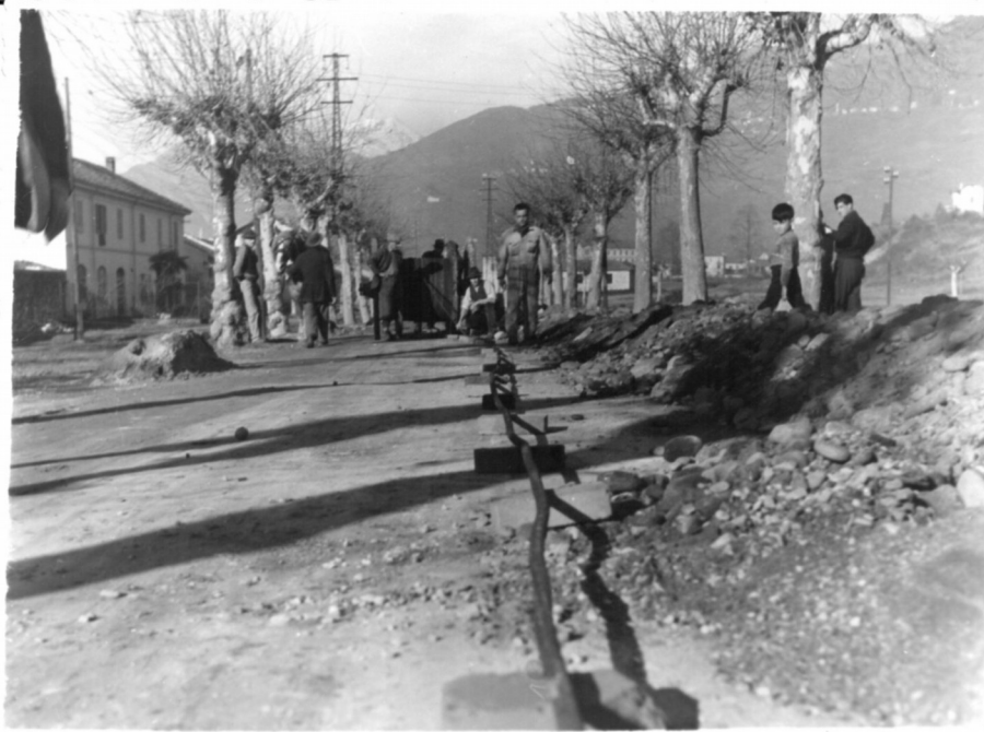
Stesura del cavo a fianco della trincea
