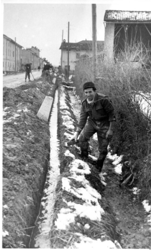
Posa cavo Alessandria - Acqui
