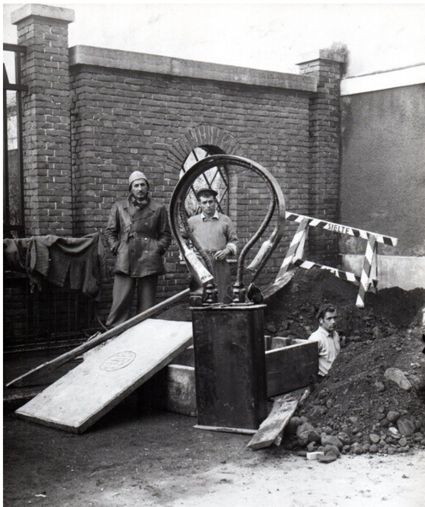
Lavori preparatori all'inserzione di cassette Pupin racchiuse in un contenitore metallico che verrà interrato nella cameretta prefabbricata
