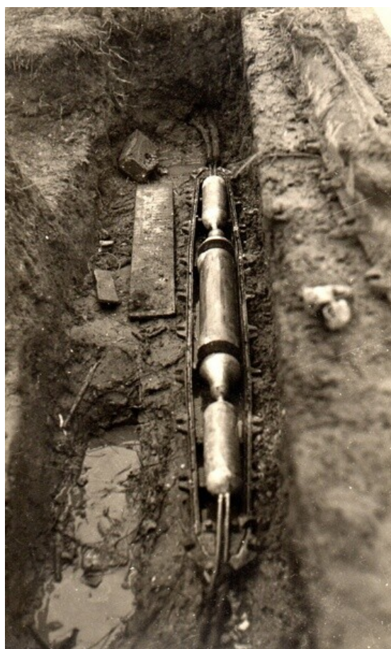
Giunto sul cavo Milano – Binasco e sistemazione nella muffola di protezione
