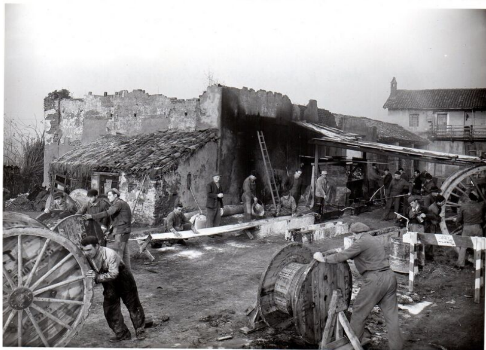
Vista cantiere. Attività di bitumatura (2 passaggi in vasca) asciugatura e arrotolamento su bobina per il trasporto.
