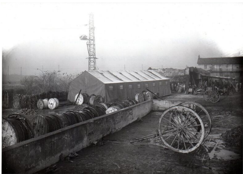
Vista cantiere su area lavoro
