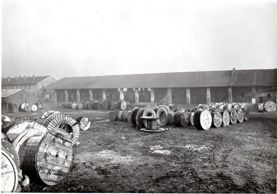
Vista cantiere su area deposito
