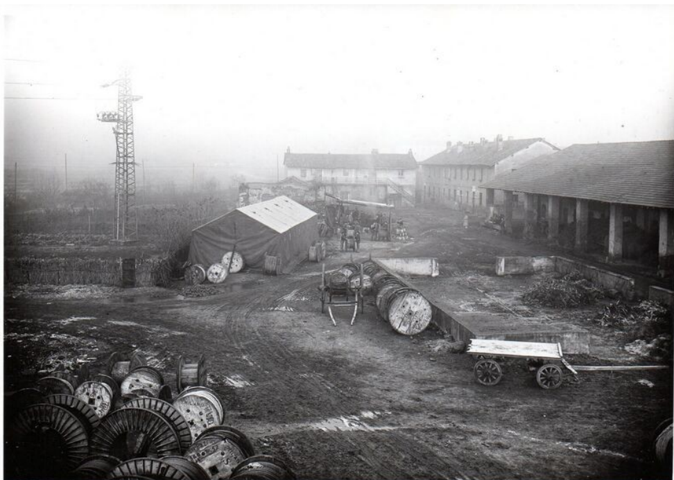
Vista generale del cantiere di prova a pressione e bitumatura cavi per la posa dell'Alessandria – Acqui e Milano - Melegnano
